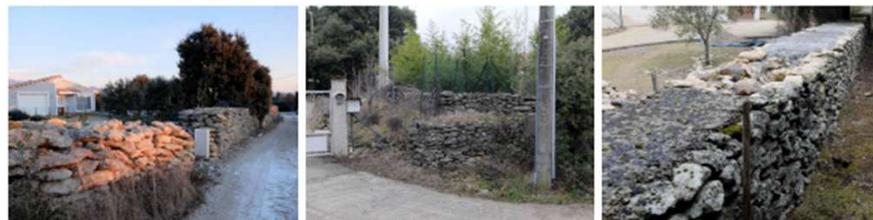
Dégradations liées à l'urbanisation : compteurs, clôtures et bétonnage des ouvrages de pierre sèche
