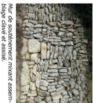
Mur de soutènement mixant assemblage clavé et assisé.
